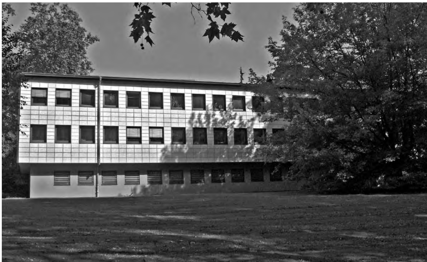
Die erst vor wenigen Jahren sanierte Parkstraße 46 ist ein Fremdkörper im Kurpark.
